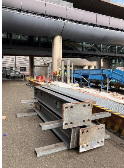
Profilé et éléments structuraux en acier 4,5 T issues du auvent
