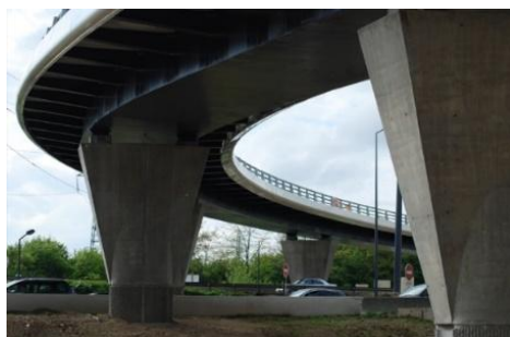
Ouvrages d'art - parkings silos
