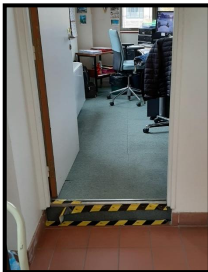
Les dalles de faux-plancher technique
