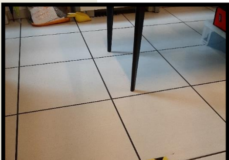
Les dalles de faux-plancher technique
