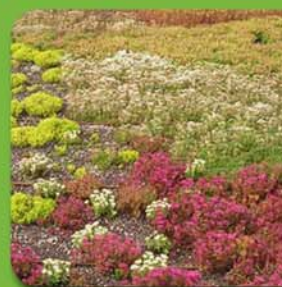
Toiture végétale en Sedum
