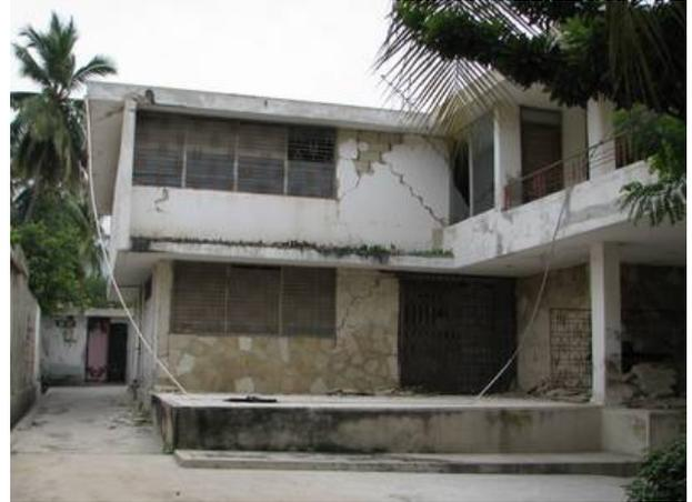
Figure 131 - Vue générale d'un bâtiment en maçonnerie contemporaine en blocs de parpaings.
