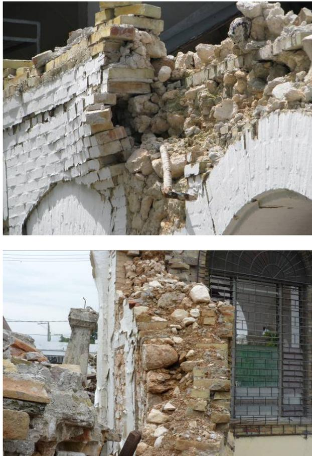
Figure 173 - Constitution des murs épais en maçonnerie de briques ou de moellons avec remplissage en tout-venant
